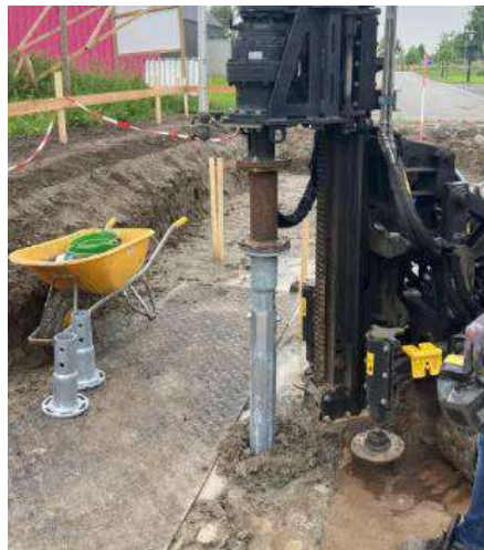
Figuur 2: Aanbrengen schroefpalen (bron: BuildinG).
