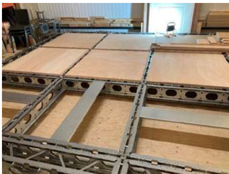
Figuur 7: Opbouw vloergrid prototype
