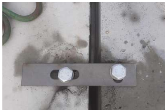
6: Horizontale koppeling tussen modules
