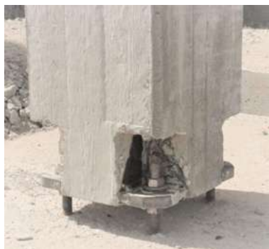
Figuur 1: Toepassing kolomschoen
