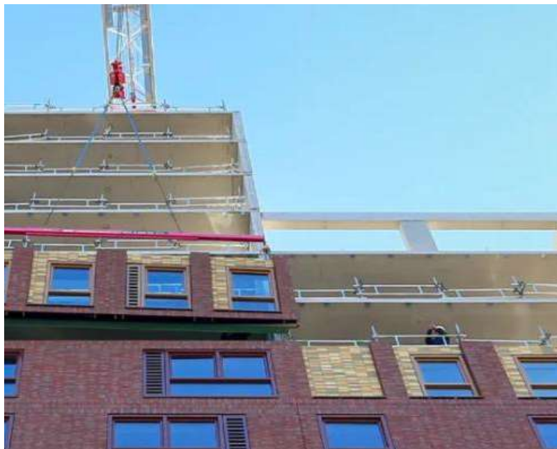
Figuur 3: Plaatsing steigerloze HSB-elementen
