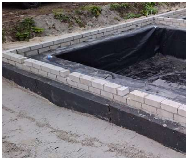
Figuur 1, 2 en 3: Starterswoning op terrein bij BuildinG te Groningen (Zernike). Prefab funderingsblokken (fabrikant GREEN Recycling Company) o.b.v. een kunststof recyclaat (bron foto's: Ingenii Bouwinnovatie).
