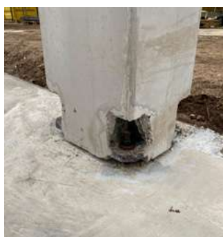
Figuur 1: Toepassing kolomschoen
