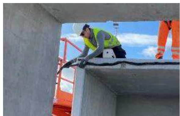
Figuur 6- Modulo elementen uit een bestaande constructie (KCA-depot) worden hergebruikt
