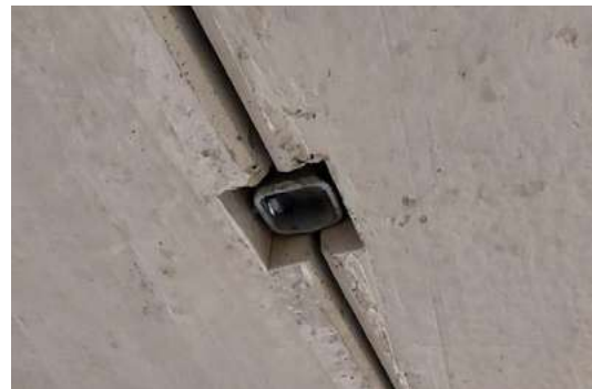
Figuur 2: Koppeling van U-modules tegen elkaar
