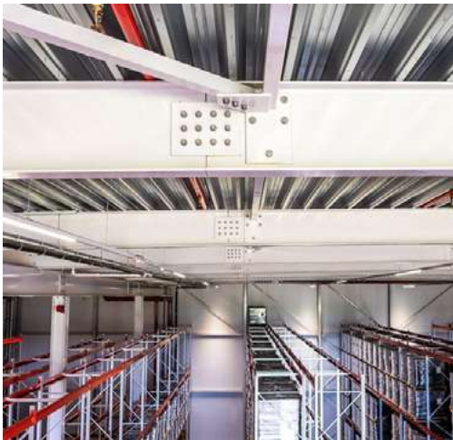
Figuur 1: EECULAIR verbindingen tussen balken
