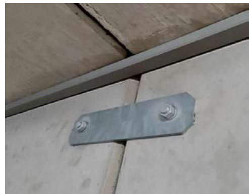
Figuur 4: Koppeling van U-modules tegen elkaar
