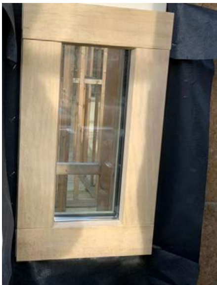
Figuur 6 — Totaalbeeld kozijn
