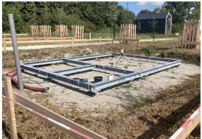
Figuur 3 en 4: Starterswoning op terrein bij BuildinG te Groningen (Zernike). Toepassing schroeffundering met stalen randbalk. (Bron: BuildinG)
