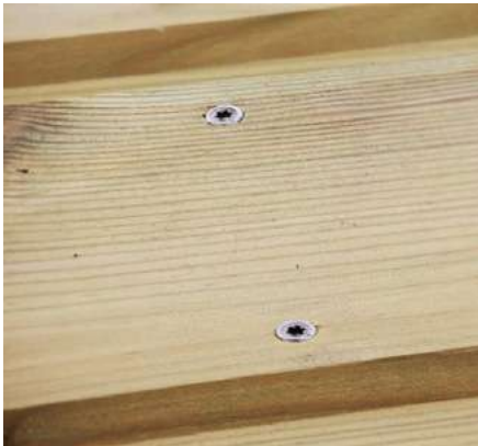
Figuur 1: Schiet-schroefnagels in houten ondergrond
