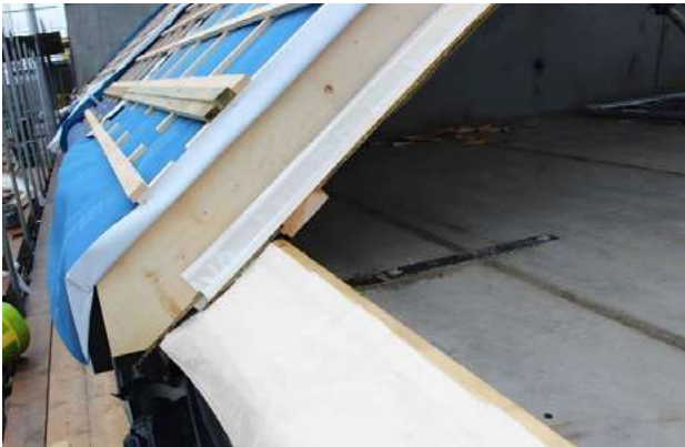
Figuur 1 : Airtight — aansluiting op prefab dakelement
