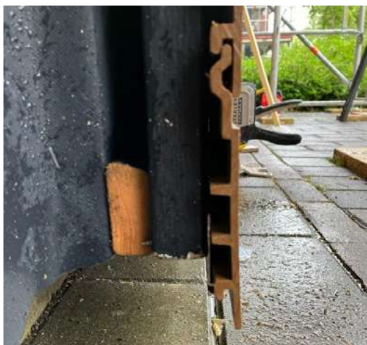
Figuur 2: Gevelpanelen - zijaanzicht
